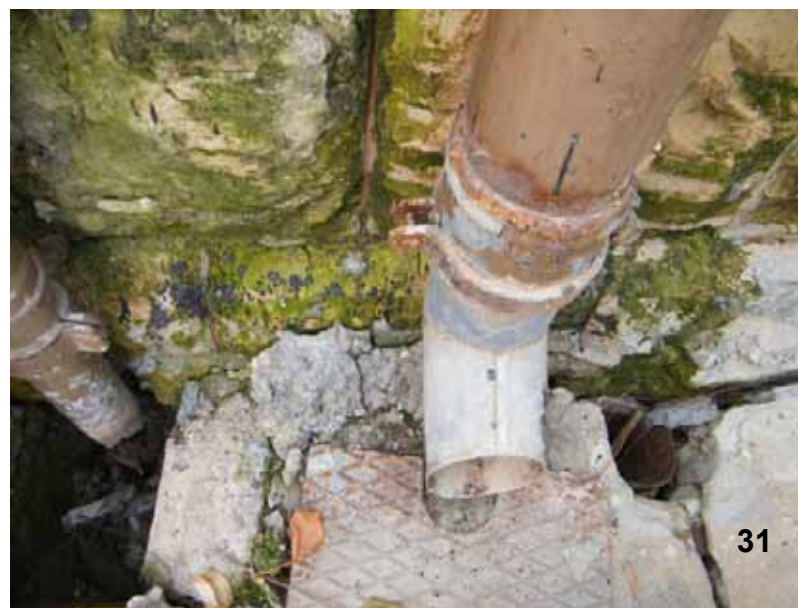
31. התפתחות של בליה ביולוגית על פני האבן בסמוך לנקודת יציאת המים מצינור הניקוז בחצר
