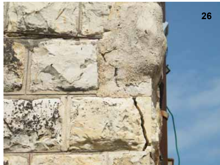
26. אבן סדוקה בחזית הדרומית כתוצאה ממאמצים שהופעלו עליה בזמן תזוזות המבנה
